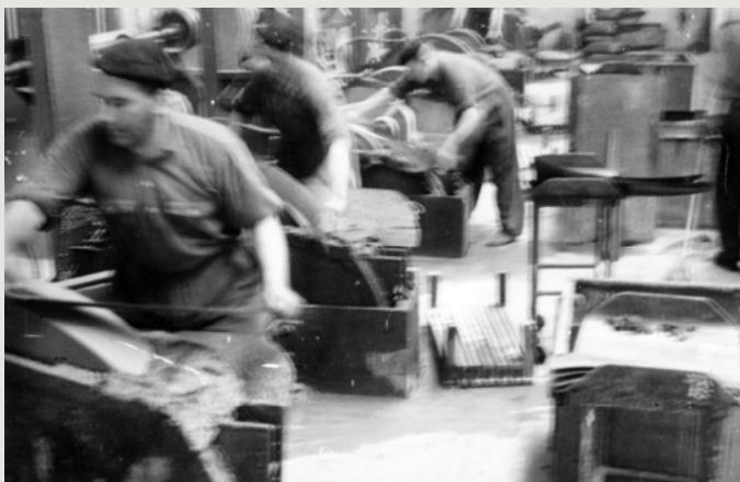
Afilado del corte de la guadaña en piedra de agua. A la derecha, secaderos. Arg: Bellota Htas. S.A.
