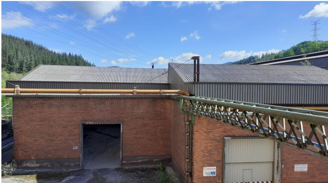
*Fotografía de la cubierta de uralita de doble capa*
